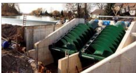
7,5 Kubikmeter Unstrutwasser werden pro Sekunde durch jede der Schnecken laufen und sie antreiben, wenn das Kraftwerk erst mal in Betrieb ist. Foto: Wilhelm Slodczyk
