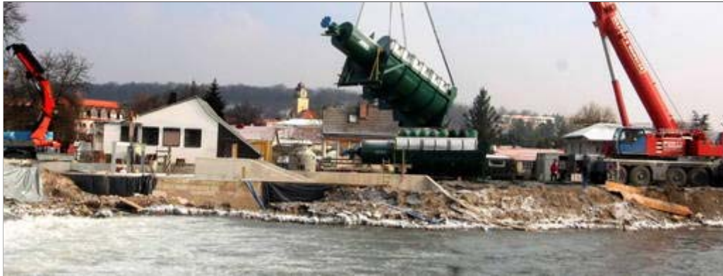
24 Tonnen wiegt jede der gewaltigen Wasserschnecken, die gestern in das Kraftwerk am Arterner Wehr einschwebten. Foto: Wilhelm Slodczyk
