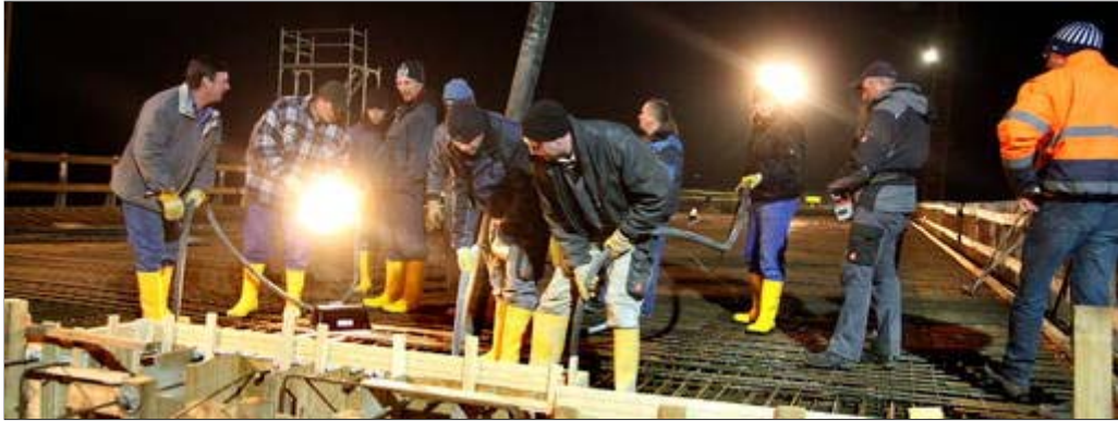
In einem Zug musste und wurde die erste Autobahn-Spur auf der 116-Meter-Flutgrabenbrücke bei Artern betoniert werden. Foto: Wilhelm Slodczyk
