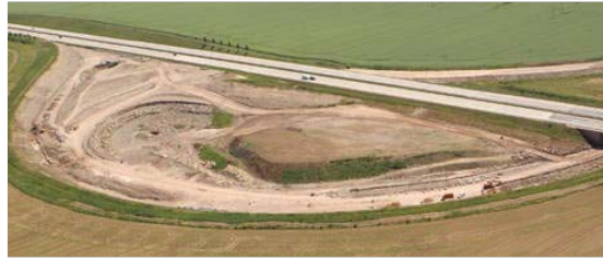
Die Bauarbeiten an der A 71 verzögern sich. Im Bild ist eine ältere Baustelle zu sehen. Foto: Wilhelm Stoc
